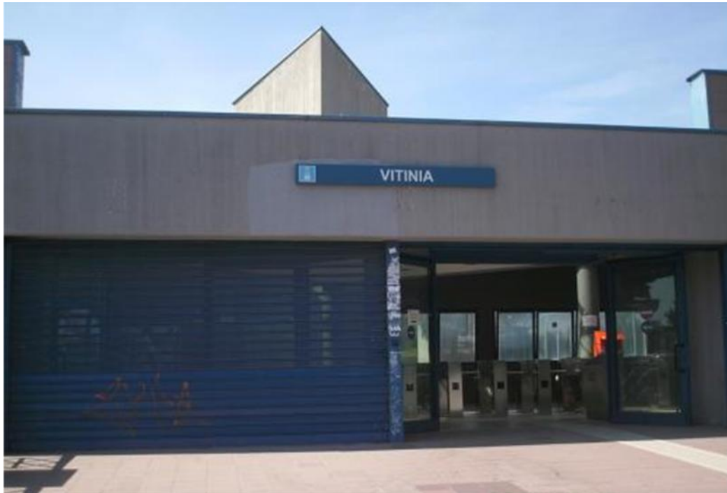
Biglietteria chiusa alla Stazione di Vitinia
