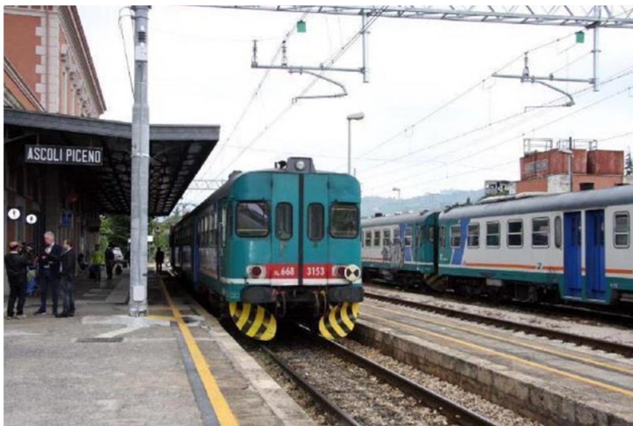
Elettrificazione lungo la linea Ascoli-Porto d'Ascoli.
