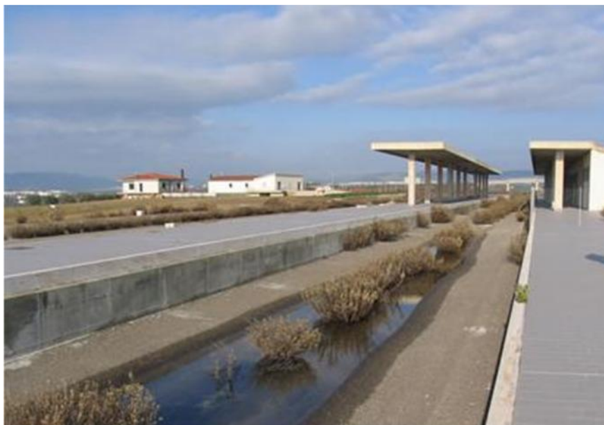
I binari della stazione mai terminata di Matera
